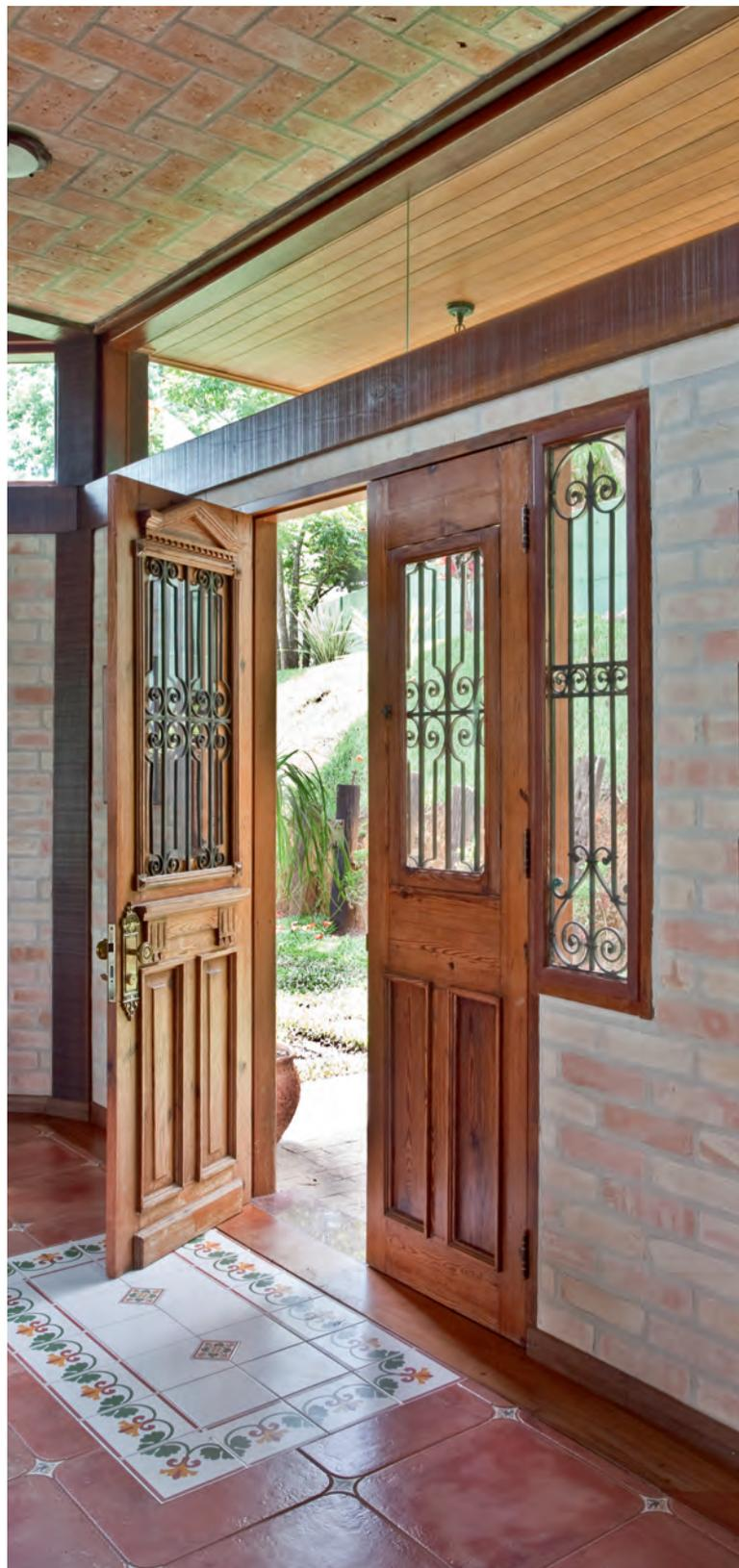
Logo na entrada, encontramos um piso de cerâmica que imita ladrilho hidráulico. Por ser da mesma espessura do restante do revestimento dos ambientes sociais foi facilmente assentado. Os tijolos da construção receberam lixamento e aplicação de resina à base de água e as grades da porta foram feitas sob medida, com desenhos planejados para combinar com a porta de entrada feita com pinho de riga.
